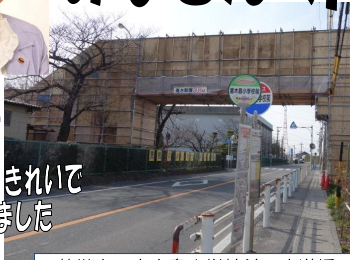
整備中の富木島小学校前の歩道橋
